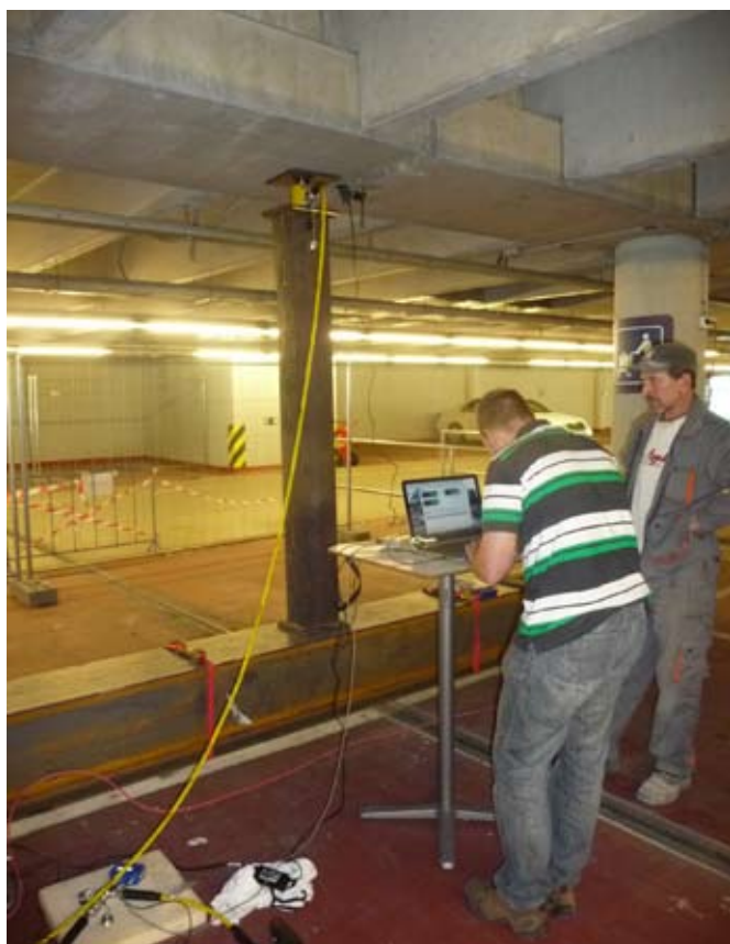
Zvedání konstrukce pro opravu uložení tyčových prvků
